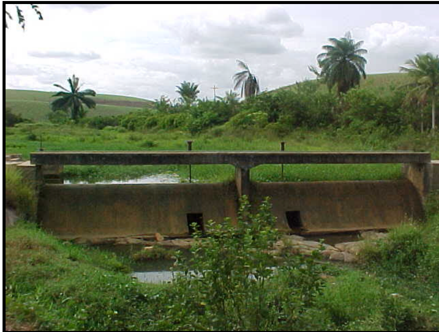
Foto 1 – Barragem da COMPESA situada no rio Sapucagi. Escada.
