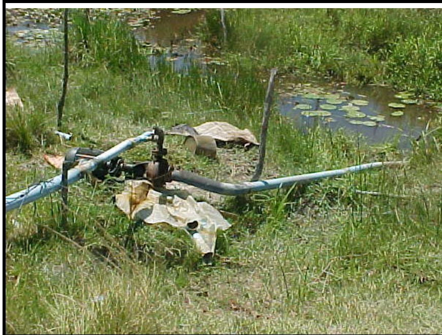
Foto 2 – Captação de água para irrigação no rio Vertentes. Chã Grande
