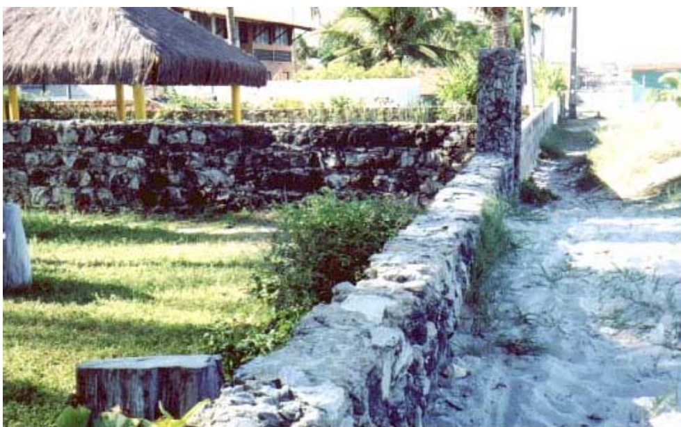
FOTO 53 – Muro de residência de veraneio construído com material extraído de recifes orgânicos (“pedras do mar”), na Praia de Jaguaribe (Itamaracá).
