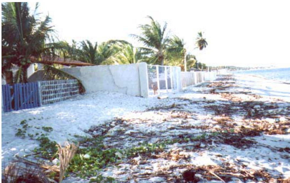
FOTO 48 – Avanço de muros na faixa de praia, em Catuama (Ponta de Pedras, Goiana).
